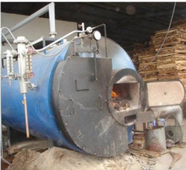
Lò sấy gỗ công nghiệp bằng hơi nước.
